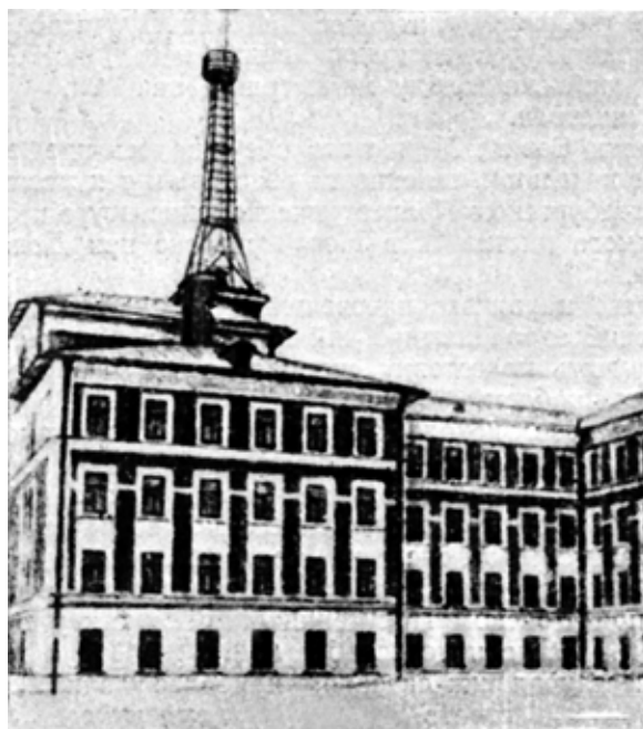
Рис. 2. Здание аэродинамической лаборатории Петербургского Политехнического института
